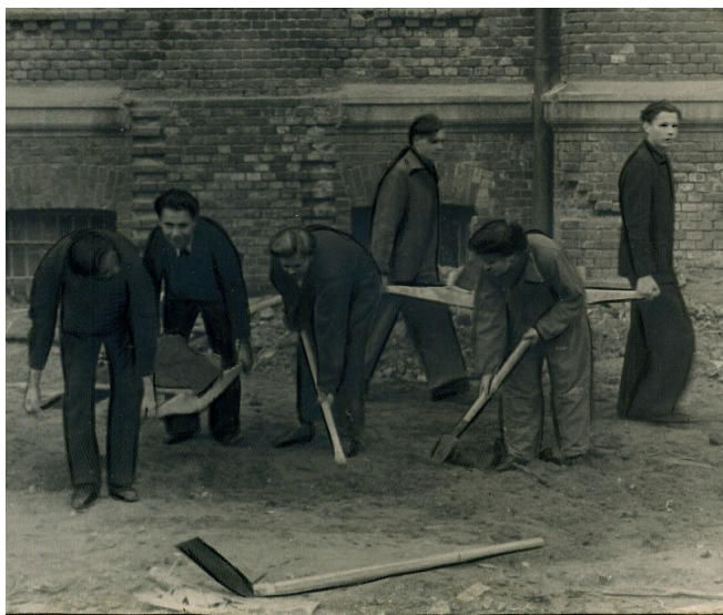
Ремонт физико-химического корпуса 1950 г. , 14 группа III курса ИФХ:
