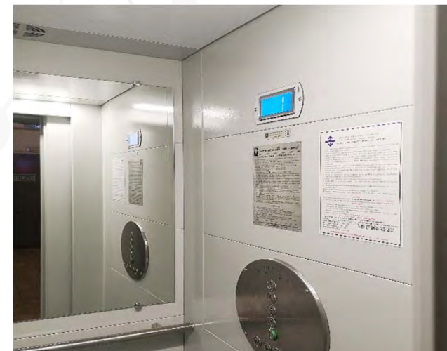
Замена лифтов в МК
