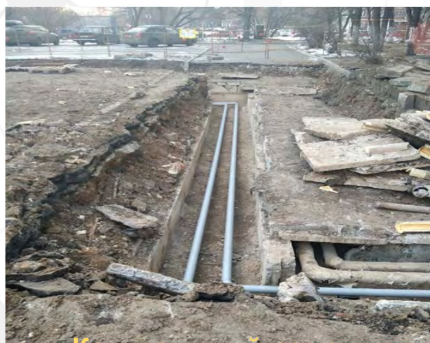
Капитальный ремонт инженерных коммуникаций СГ
