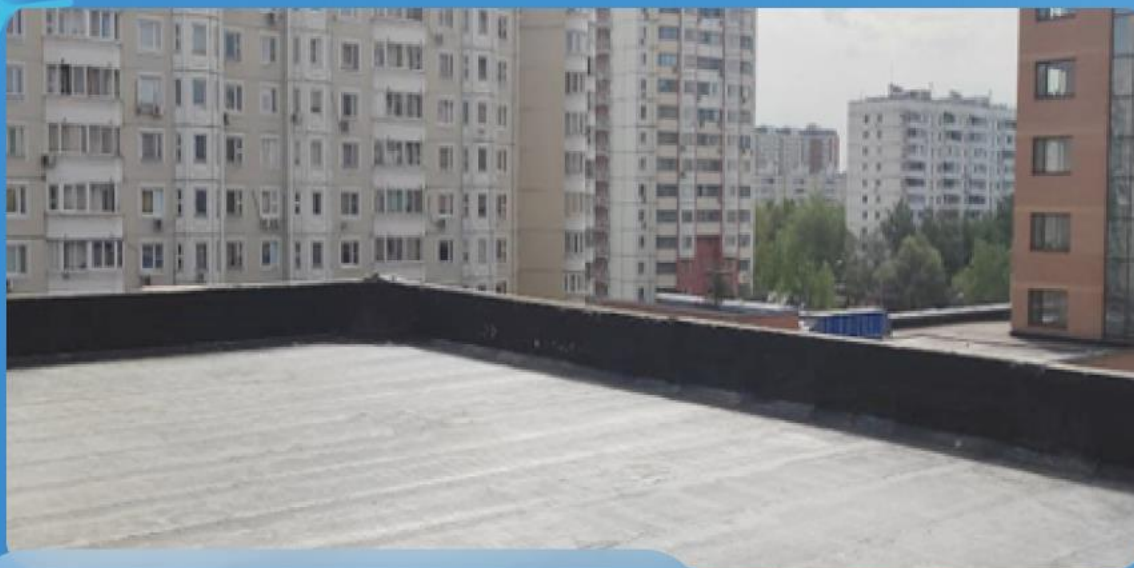
Кровля здания Силикаты
